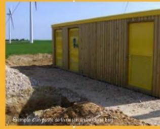
Exemple d'un poste de terre en bois pour l'enfouissement des câbles.
